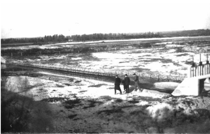
La visite du chantier de l'aqueduc, de l'écluse et de la digue à Moustierlin par André Bénac et ses ingénieurs en 1935. Au fond la dune, la plage et les marais
